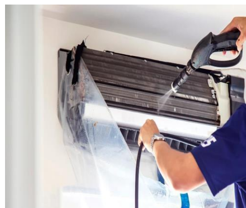
Proceso de limpieza intercambiador (proelectrica).
